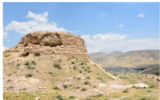
شکل (۴). نمای شمالی برج غربی قلعه فهندژ (حسینی، ۱۴۰۳)
